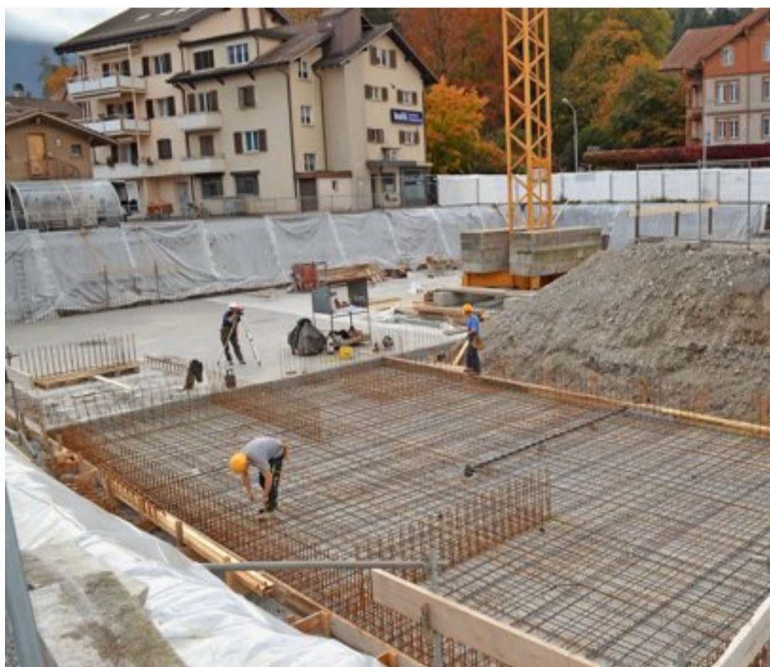
Gegenüber dem Hotel Sonne entsteht auf dem ehemaligen Areal der Gärtnerei Gosteli ein Mehrfamilienhaus mit insgesamt 13 Wohneinheiten, einem Verkaufslokal und einer Einstellhalle. Monika Hartig
