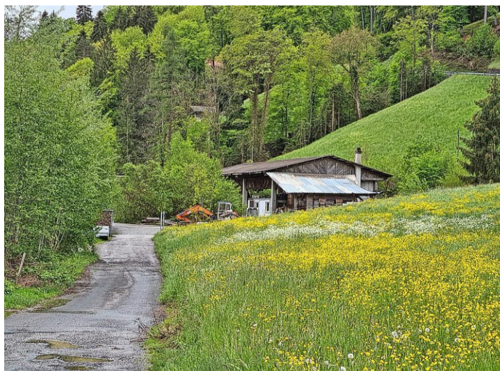
Von dieser stillgelegten Sägerei bei der Birmse muss am vergangenen Donnerstag eine Verunreinigung in den Lombach (links, unsichtbar) gelangt sein. Foto: Hans Peter Roth
