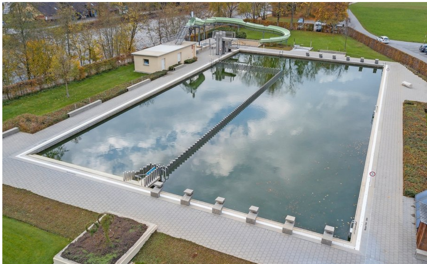
Der defekte Rücklauf soll bald mit dem Inlinerverfahren repariert werden. Die Abtrennungsposten werden durch ein Lochblech ersetzt. Patrick Spahnli
